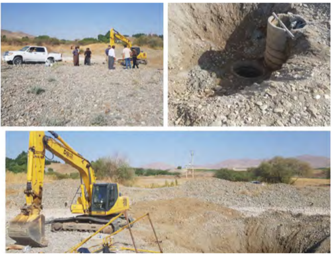
چاه تامین آب شرب صاحب سقز با توجه به کاهش دبی لایروبی و ترمیم شد.
