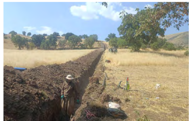
انجام پروژه تعویض و اصلاح خط انتقال آب روستای ژریژه شهرستان سروآباد
