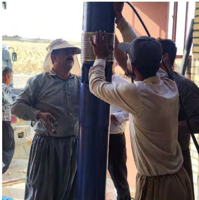
رفع مشکل کمبود آب شرب روستای قروچای دهگلان با جمعیت حدود ۱۲۰۰ خانوار با تجهیز و راه اندازی چاه شماره ۲
