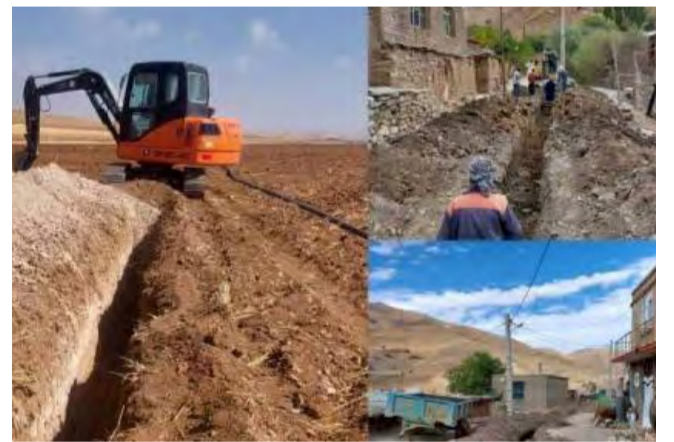
اجرای بیش از ۳۷۰ میلیارد ریال پروژه آب و فاضلاب در شهرستان دیواندره
